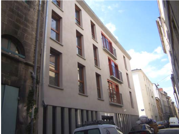
Façade rue Carpenteyre
